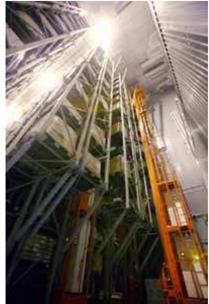
現在の工場内
