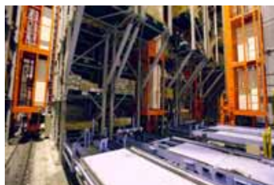
立体自動倉庫
