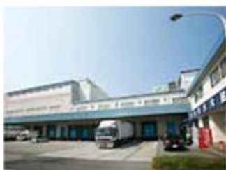
箱崎物流センター
